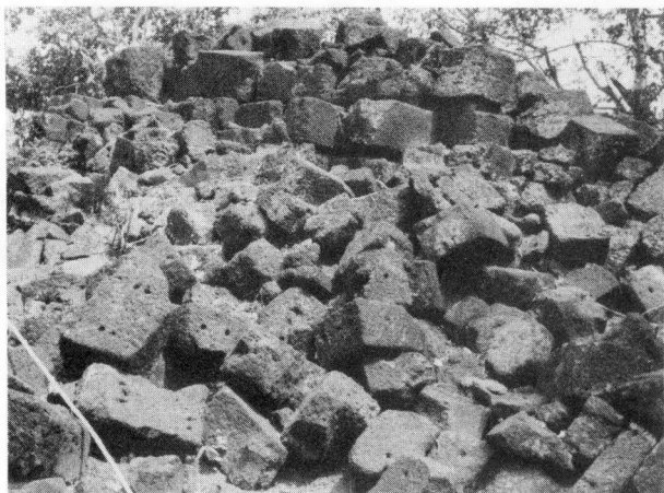
๕ บริเวณปรังก์ประธาน ด้านทิศตะวันออกเฉียงใต้ที่พังทลาย ยังไม่ได้ขุดแต่ง
