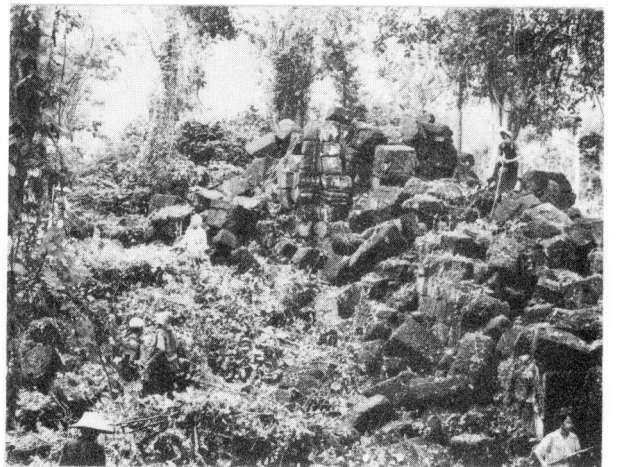
๓ บริเวณปราสาทเมืองสิงห์ ด้านทิศตะวันออก คนงานกำลังถากถาง
