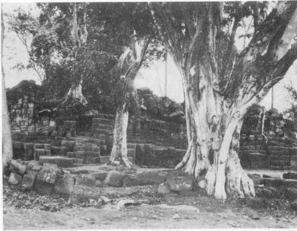
๗-๘-๙-๑๐-๑๑ บริเวณปราสาทเมืองสิงห์ด้านทิศเหนือ เมื่อดูแล้วเสร็จ และนำก้อนศิลาแลงที่พังทับ ถมออกมาเรียงให้เป็นระเบียบ เพื่อเตรียมการบูรณะต่อไป
