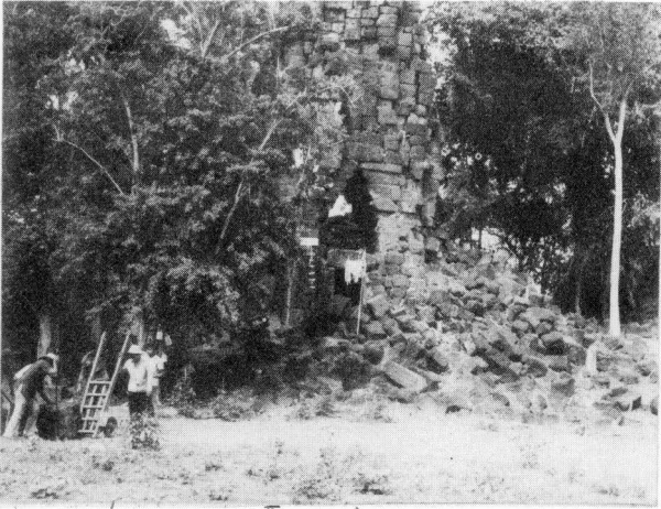
๖-๗ บริเวณปราสาทเมืองสิงห์ ด้านทิศตะวันตก ก่อนทำการขุดแต่ง
