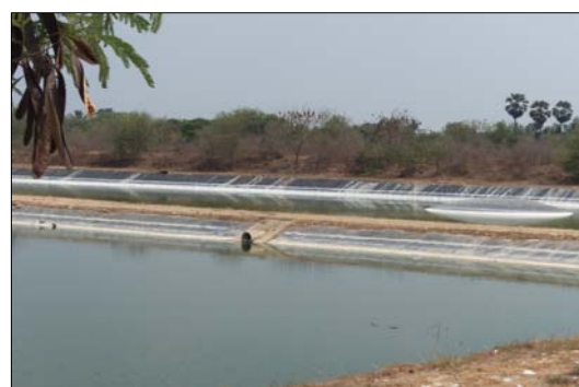
รูปที่ 3.2.1-3 ระบบบำบัดน้ำชะขยะมูลฝอย
