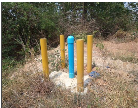
รูปที่ 3.1.2-6 บ่อสังเกตการณ์ (MW2) ที่ซ่อมแซมเรียบร้อยแล้ว
