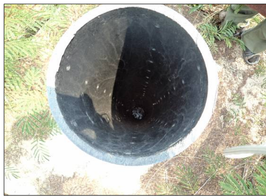
รูปที่ 3.1.1-7 บ่อติดตามตรวจสอบคุณภาพน้ำใต้ดิน
