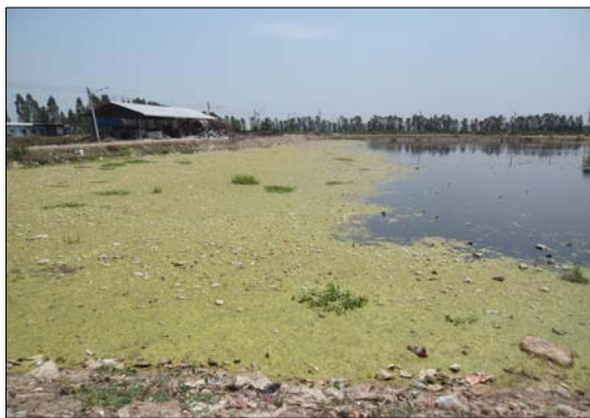
รูปที่ 3.2.2-6 บ่อบำบัดน้ำเสียบ่อที่ 3
