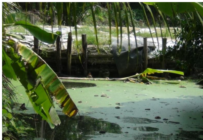
รูปที่ 5-6 คันกันน้ำเข้าพื้นที่สวนของประชาชนที่อาศัยอยู่ในบริเวณหลังโรงเรียนนายร้อยสามพราน
