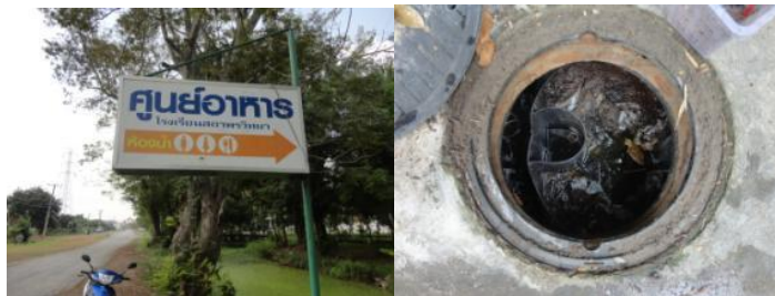
รูปที่ 5-11 บ่อดักน้ำทิ้งจากโรงอาหารของโรงเรียนสถาพรวิทยา
