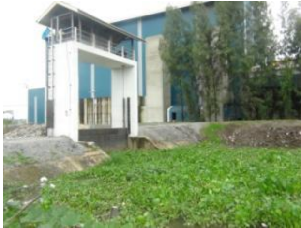
รูปที่ 5-3 วัชพืชสะสมหนาแน่นบริเวณประตูน้ำติดคลองพระพิมล
