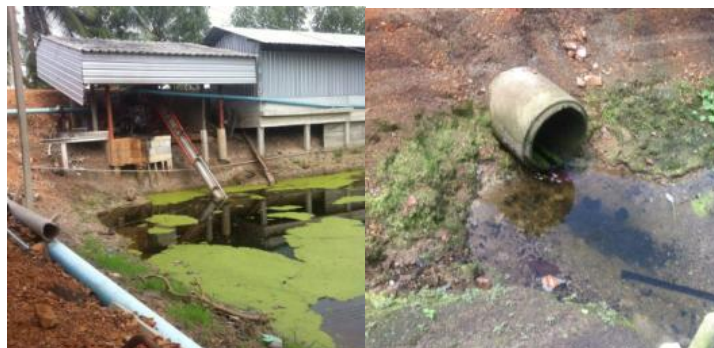
รูปที่ 5-10 (1) บ่อพักน้ำในสวนกล้วยไม้ (2) และท่อระบายน้ำทิ้งจากร่องน้ำในสวนกล้วยไม้
