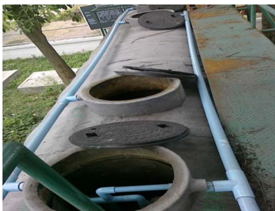
รูปที่ 2.16 ถังบำบัดน้ำเสีย และท่อนำน้ำเสียชำรุด ไม่สามารถใช้งานได้
