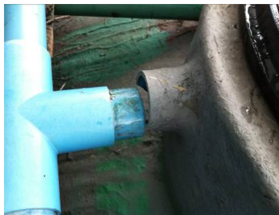
รูปที่ 2.16 ถังบำบัดน้ำเสีย และท่อนำน้ำเสียชำรุด ไม่สามารถใช้งานได้
