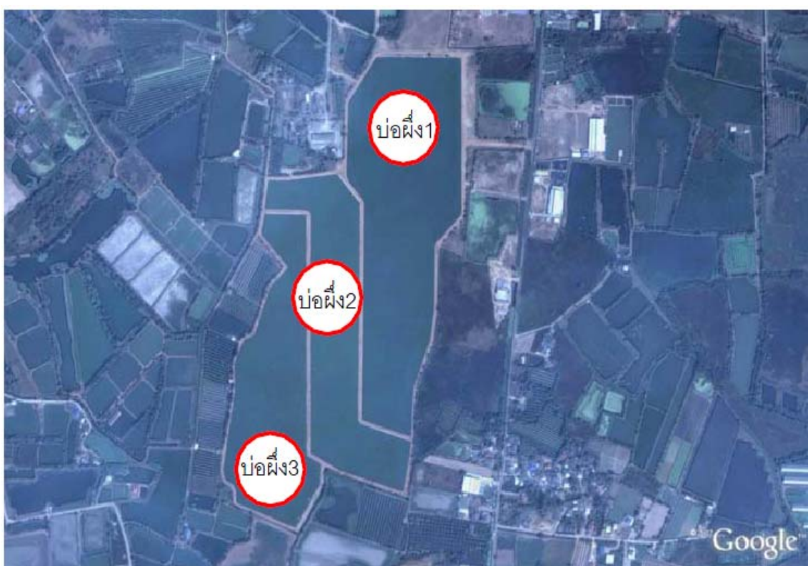
รูปที่ 2.15 ระบบบำบัดน้ำเสียเทศบาลนครนครปฐม
