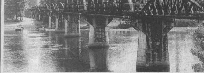
ภาพปัจจุบัน “สะพานข้ามแม่น้ำแคว” จ.ท่ามะขาม อ.เมืองกาญจนบุรี สถานที่ท่องเที่ยวที่มีชื่อเสียงระดับโลก ซึ่งกำลังมีการปรับปรุงภูมิทัศน์ใหม่.
