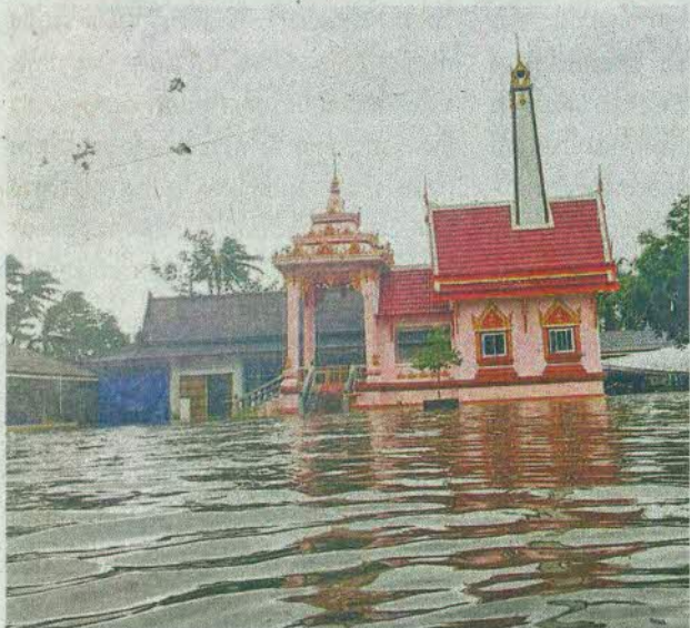
ผลจากพายุปาบึกทำให้เกิดฝนตกหนัก เกิดน้ำท่วมสูงหลายพื้นที่ในเขตเทศบาลนครศรีธรรมราช
