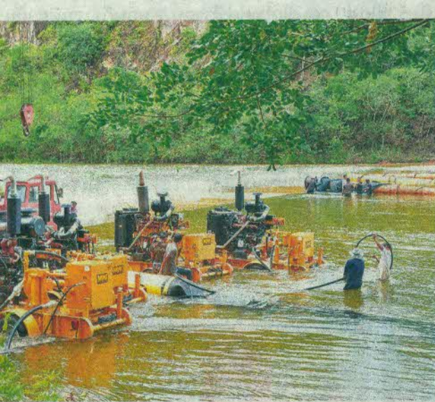
กรมชลประทานนำเครื่องสูบน้ำ 5 เครื่อง ไปวางบนสันดอนเหนือแม่น้ำบริเวณลพบุรี เพื่อเร่งระบายน้ำ เมื่อวันที่ 7 สิงหาคม
