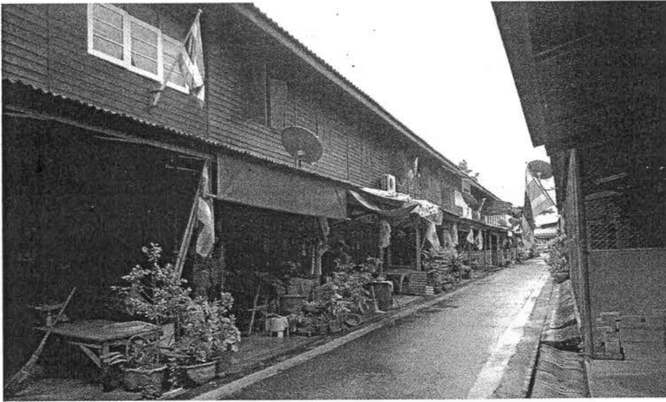
(ซ้าย) ตลาดจรัญรายประกอบด้วย เรือนแถวค้าขายสองฝั่งของถนน ที่ตัดผ่านกลางตัวตลาด ซึ่งจะตรงลงสู่หน้าในที่ในอดีต เคยเป็นที่ตั้งของท่าเรือเมล์ (ซ้ายล่าง) บริษัทสุพรรณชนสง จำกัด สำนักงานตั้งอยู่บริเวณหน้า ของตลาดจรัญราย ซึ่งปัจจุบัน ถูกรื้อออกไปแล้ว
