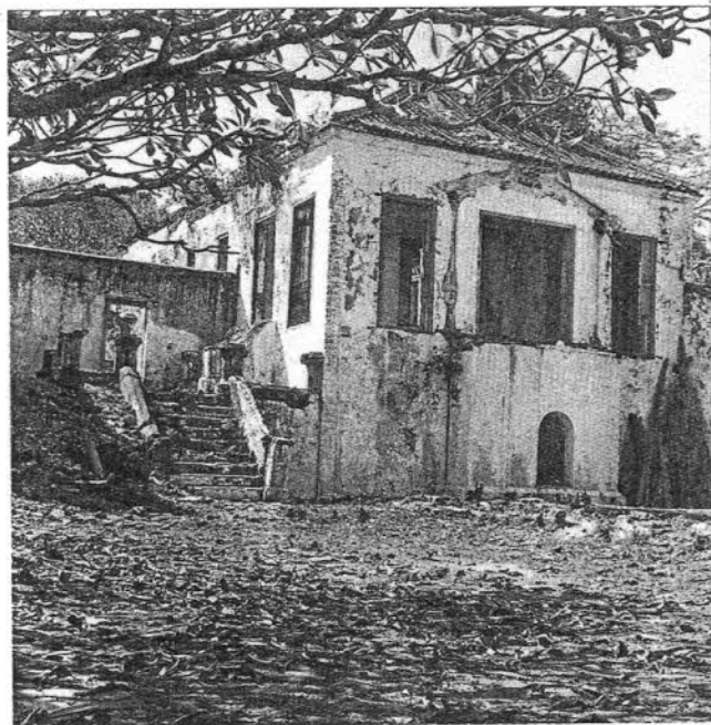
อาคารในเขาวัง เพชรบุรี A building at the royal palace.
