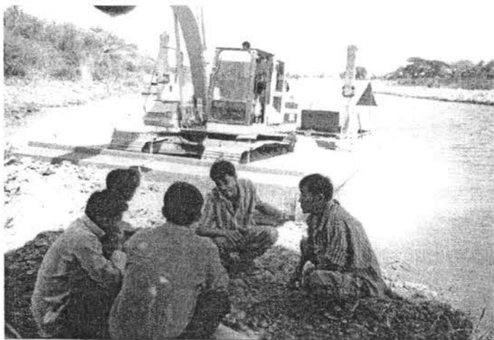
การขุดลอกดินบริเวณบ้านบางคาง คลองพระยาพาน
