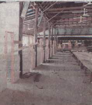
ในวัดกำลังอยู่ระหว่างก่อสร้าง
