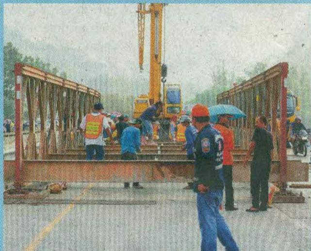
เจ้าหน้าที่กำลังเร่งเสริมเหล็กเพิ่มความแข็งแรงให้แก่สะพานบ้านวังยาว ถนนเพชรเกษม อ.บางสะพาน จ.ประจวบคีรีขันธ์
