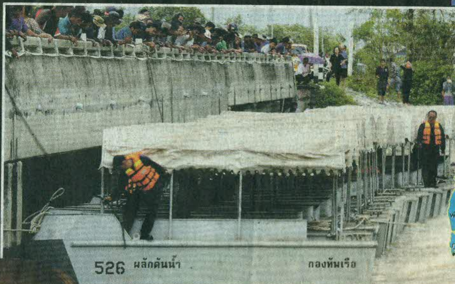
■ ดันน้ำ ■ เรือผลักดันน้ำของกรมอุทกหารเรือจำนวน 20 ลำ ถูกติดตั้งบริเวณปาก ถูกเงิน ค.บางพระ อ.ปากพนัง จ.นครศรีธรรมราช เพื่อเร่งระบายน้ำลงสู่อ่าวไทย เมื่อ
