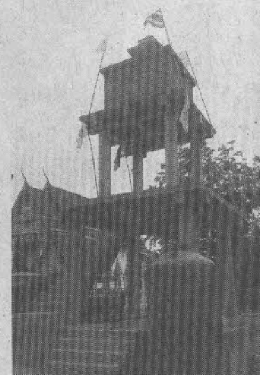
หอรบที่ตั้งอยู่ระหว่างการก่อสร้าง
