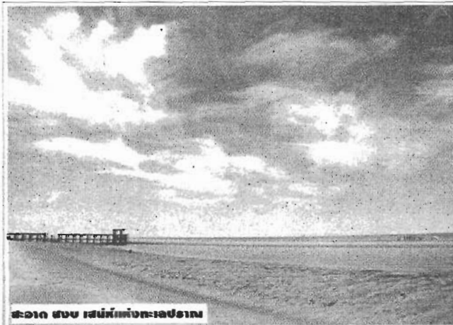
สะพาน สะพานเหล็กทะเลปราง
