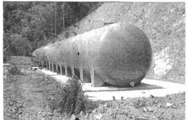
ถังเก็บน้ำในโครงการจัดหาน้ำเพิ่มเติม
