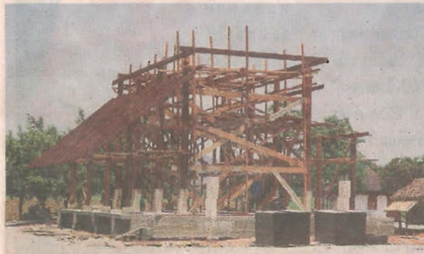
วิหารที่อยู่ระหว่างการก่อสร้าง
