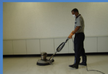
ขัดให้ทั่วบริเวณ
