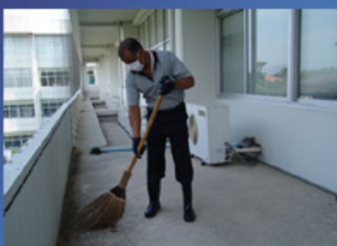
เก็บกวาดบริเวณ
